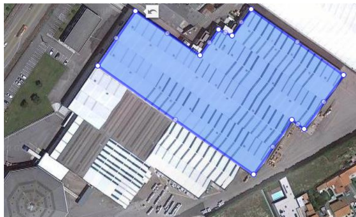
FIGURA 48. ESPAÇO A INSTALAR OS MÓDULOS FOTOVOLTAICOS [61]
